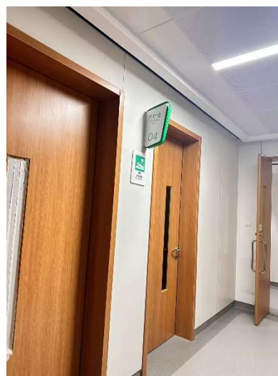
机房正对楼上理疗科光疗室
